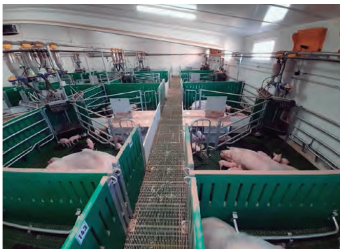
Figura 1. Detalle de una sala de maternidad visto desde uno de los pasillos longitudinales de la misma.
