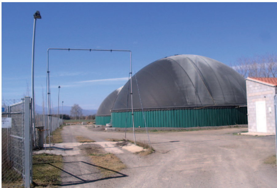
Figura 5. Entrada a una planta de digestión con arco de desinfección.
