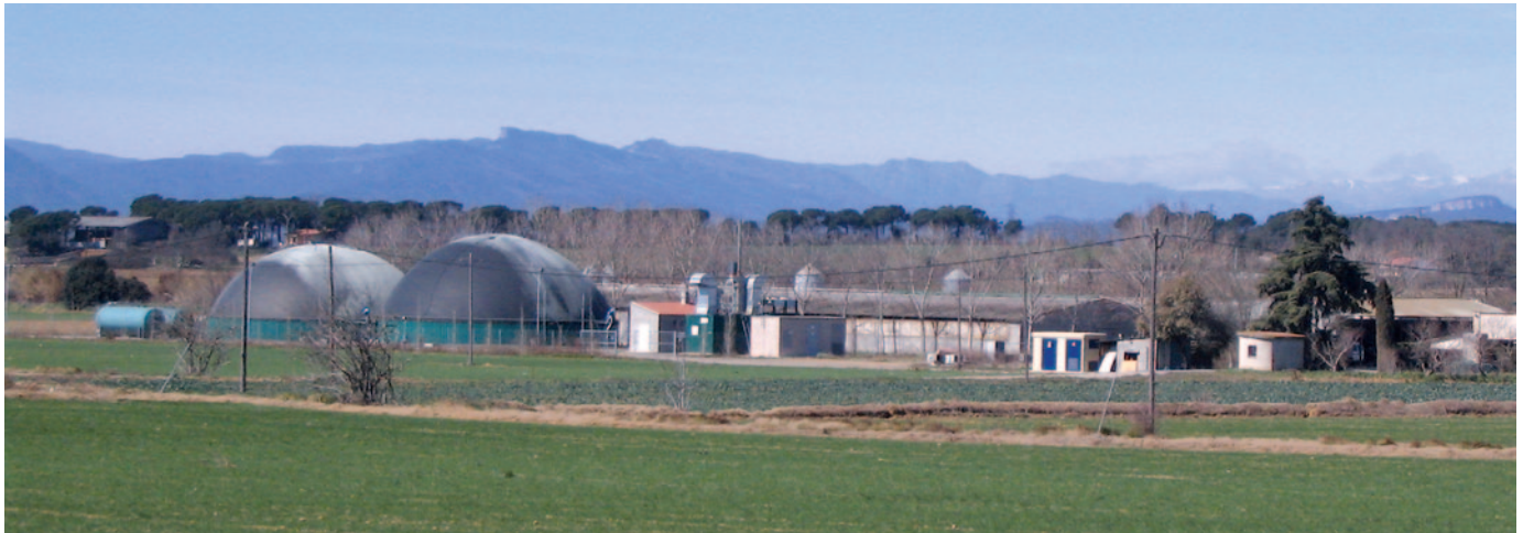
Figura 6. Vista general de una granja con los digestores.
