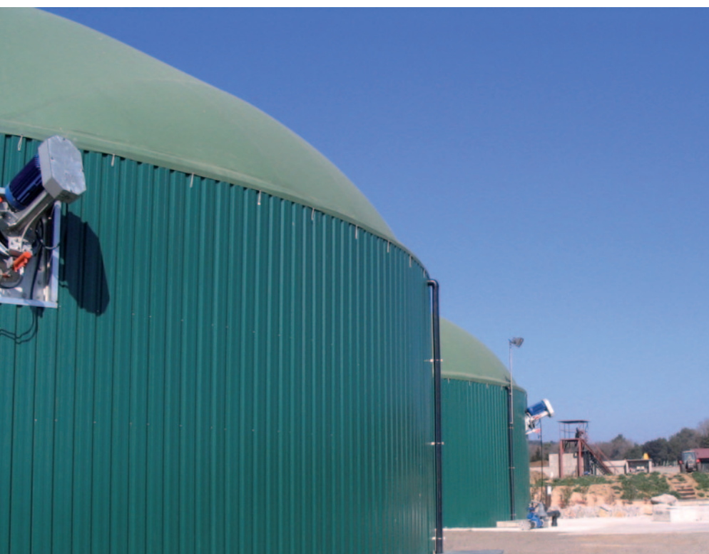
Figura 3. Biodigestores con explotación ganadera al fondo.
